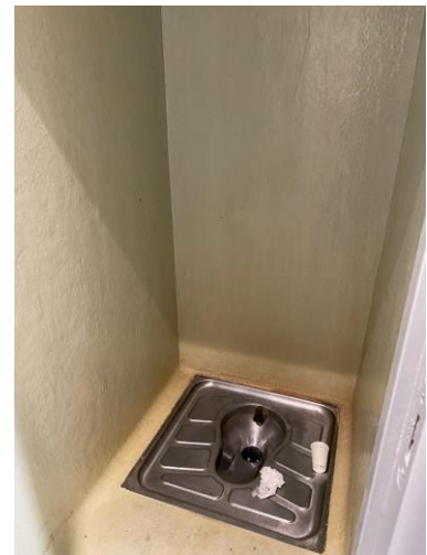
Sanitaires dans le commissariat de la rue de la Faisanderie
