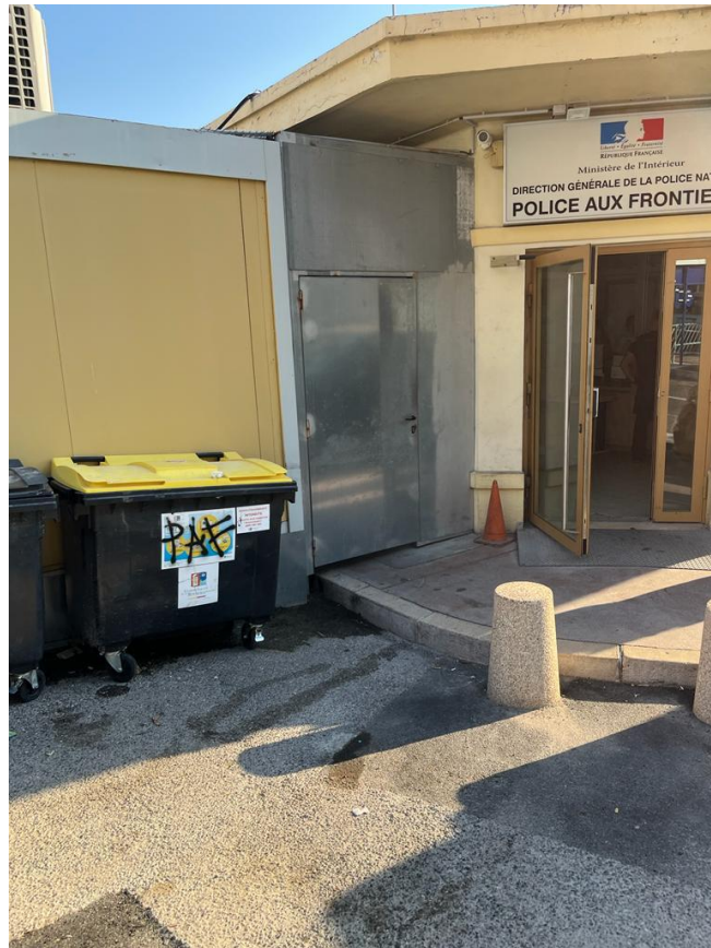
Entrée au local par la porte en métal
