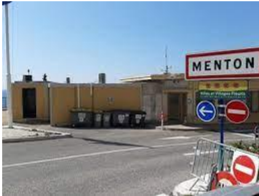
Vue générale du local de mise à l'abri
