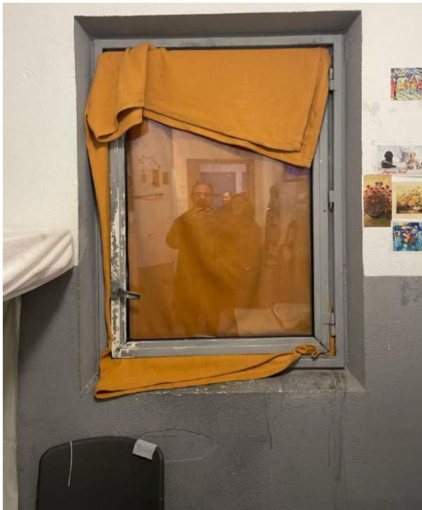
Photos de la cellule n° 23 :
