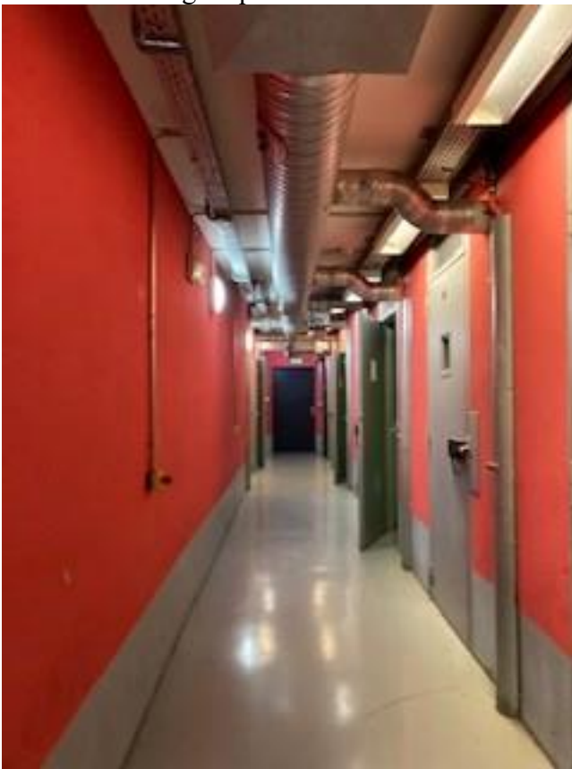
Couloir cellules de dégrisement
