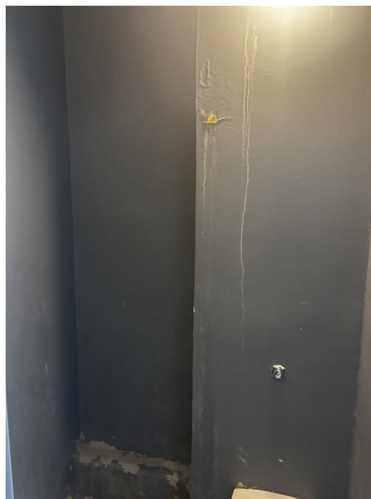
Cellule du quartier ordinaire — détail de l'espace sanitaire
