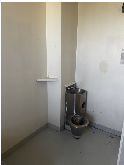
Cellule du QD — bloc sanitaire (lavabo et WC intégrés)
