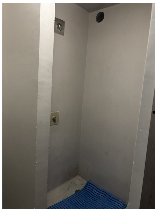
Accès à l'étage du QD (hors cellule)— espace douche
